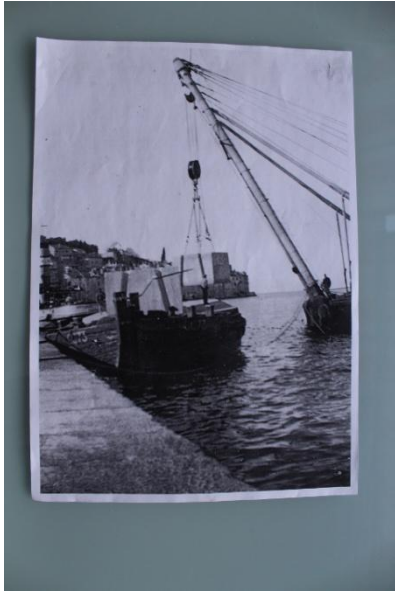
HIDRO GRADNJA RANO 20st.
